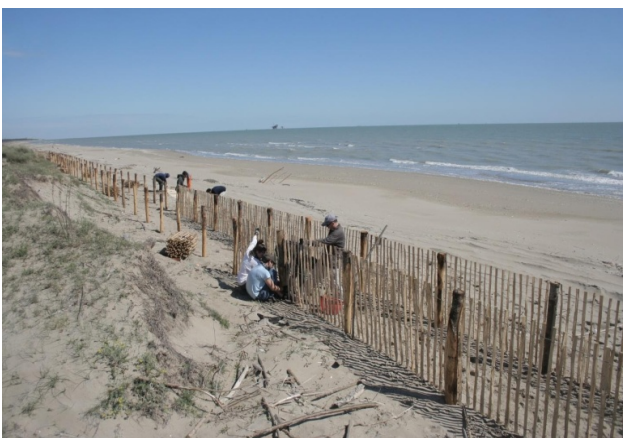
Slika 23. Gradnja i učvršćivanje obalnih dina u okolini Ravenne (Bevano Sud, Emilija i Romanja, Italija) (Fotografija: Beatrice Giambastiani)
