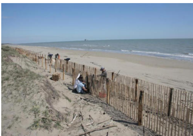
Slika 23. Gradnja i učvršćivanje obalnih dina u okolici Ravenne (Bevano Sud, Emilija i Romanja, Italija) (Fotografija: Beatrice Giambastiani)
