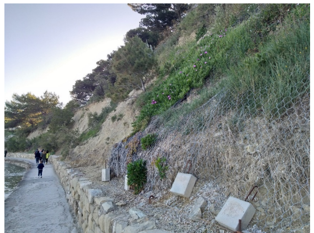
Slika 26. Zaštita obalnog klifa mrežom na plaži Firule u Splitu (Fotografija: Ivan Sekovski)
